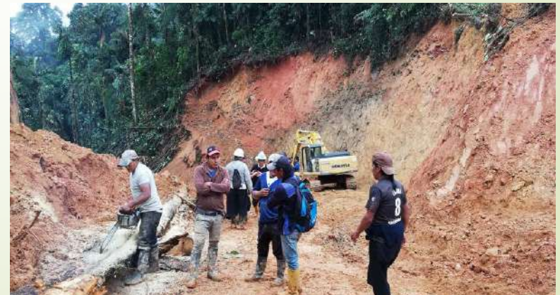
Construcción de la vía a manka - urku
