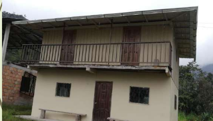
Adecuación de la casa comunal de San Vicente de Tutupali
