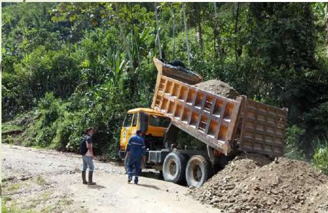
Mantenimiento vía Muchime – 28 de Mayo
