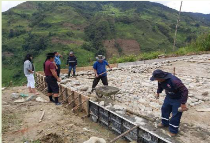
Reconstrucción de cancha comunidad Esperanza de Ortega
