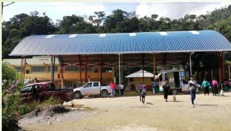
Cubierta CECIB Huayna Capac, monto $86.648,40
